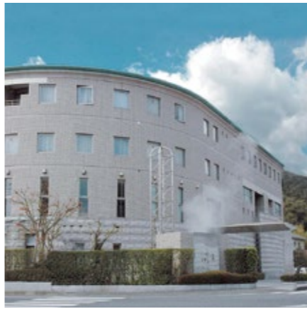
▲戸田市保養所白田の湯（静岡県東伊豆町）
