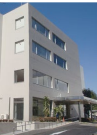
▲新曽地域包括支援センターが設置されている新曽南庁舎
